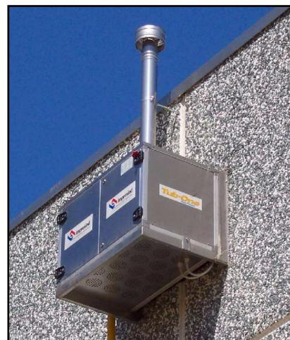
Stanovte si výšku a polohu sálavého potrubí porovnáním s vnitřním nárysem dané budovy; na vnější stěně označte správnou polohu venkovní skříně hořáku.
