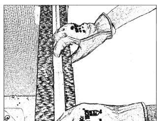
Zasuňte pásky rozvodu vody do drážek v deskách. Zkontrolujte, zda jsou pásky dobře přitisknutý ke dnu každé drážky.
