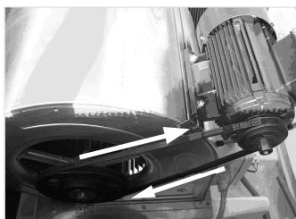
4. Otáčí-li se ventilátor nesprávným směrem, je nutné změnit zapojení napájení hlavního vypínače přehozením zapojení fází L1 a L2.
