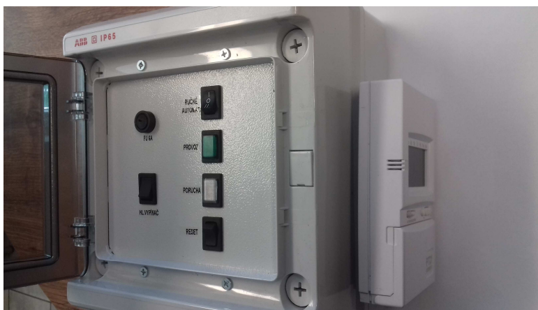
Ovl. rozvaděč SO2I
